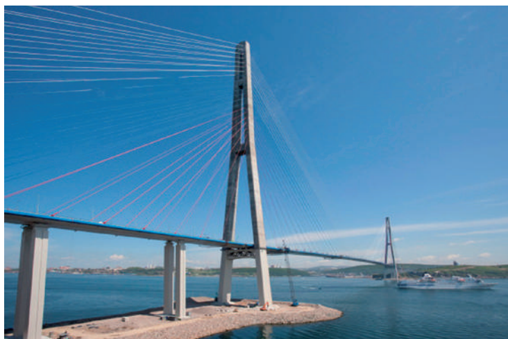
Le pont, le 27 juillet 2012 / © CKMOCT / http://rusmost.ru/
