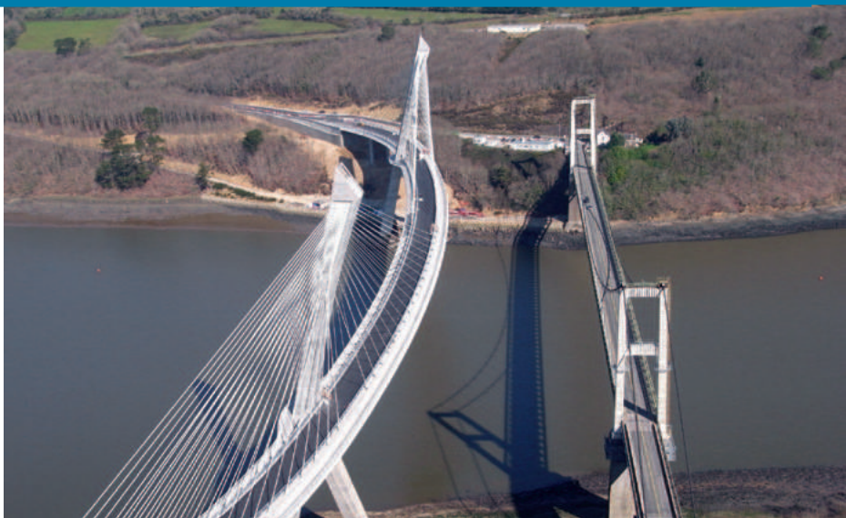
Maîtrise d'ouvrage du nouveau pont (2011) : Conseil général du Finistère
