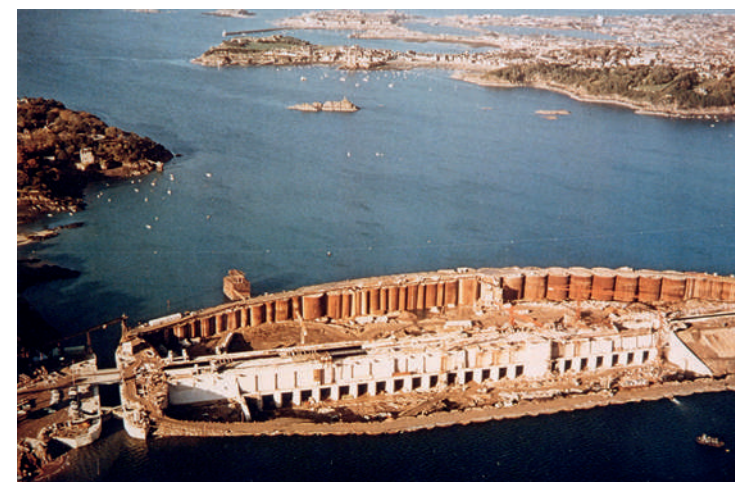
Usine marémotrice de la Rance.
